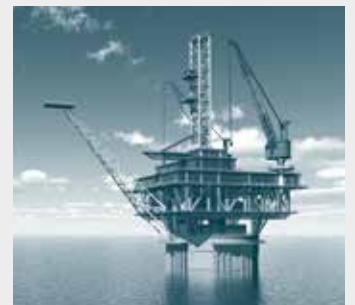
Öl- und Gasexploration
